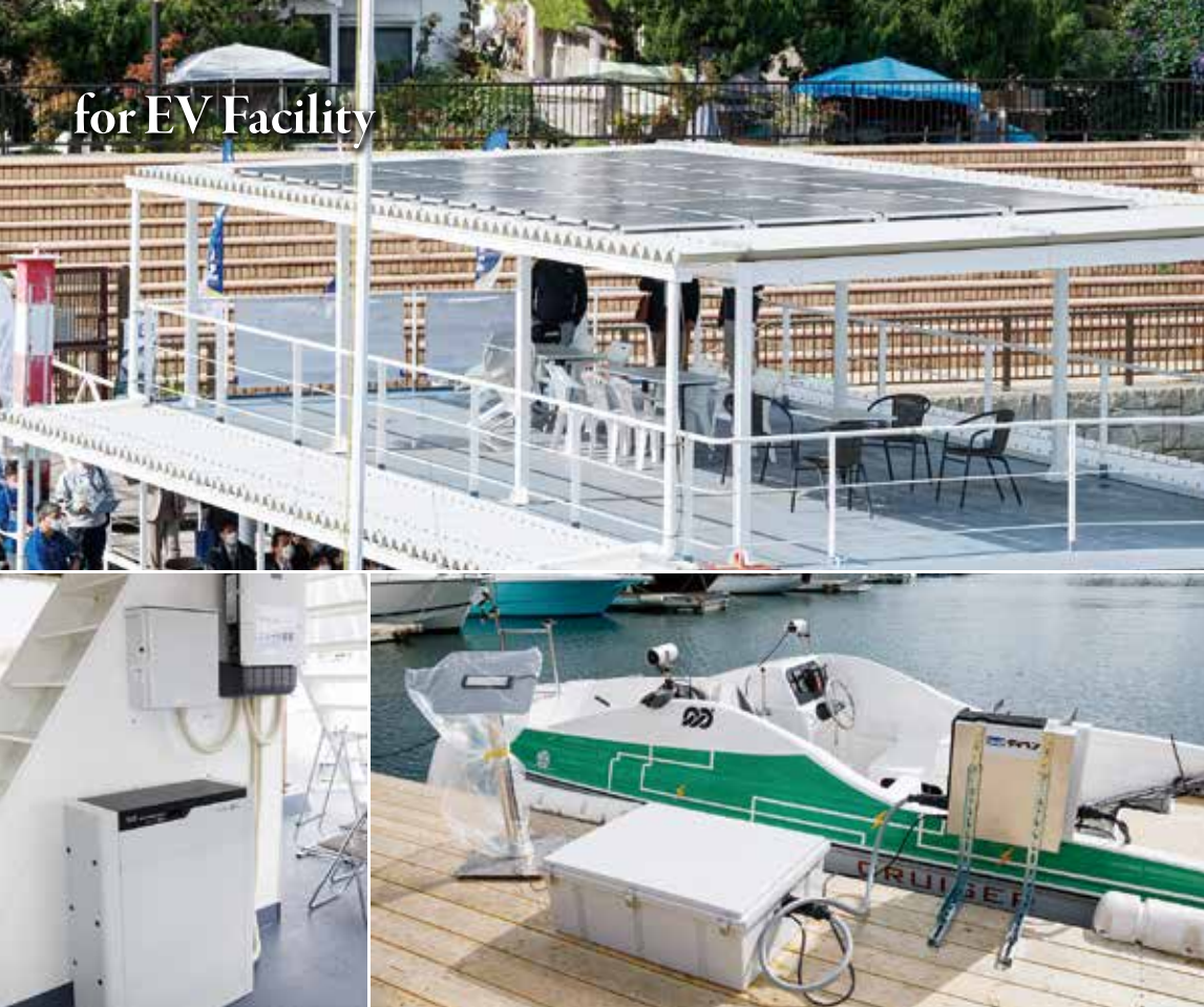
ベース基地となる台船上の建屋の天井に8kW/hの太陽光パネルを設置、デッキ上の12kW/h蓄電池に充電する。エレクトリックボートへの電源供給は、ダイヘン社製の非接触型3kW/h電源を使用。
